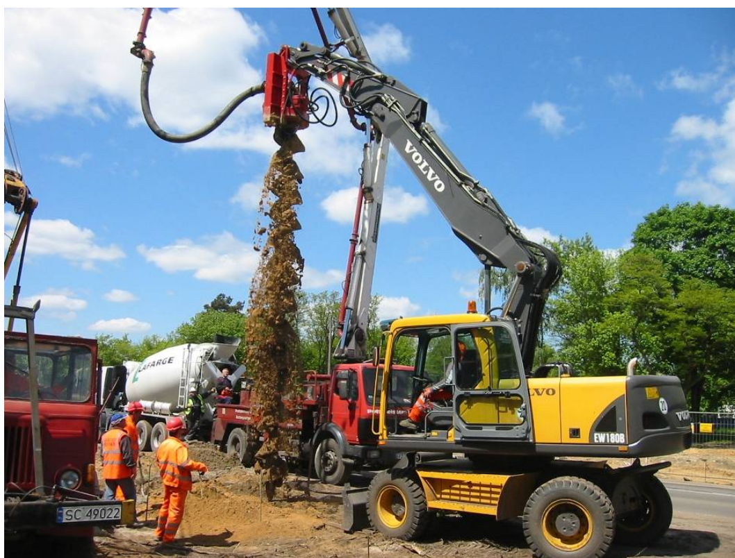
Koparkowa głowica obrotowa CFA typu OWK-3600 zawieszona na koparce kołowej Volvo EW180 – ul. Bukowska Poznań
