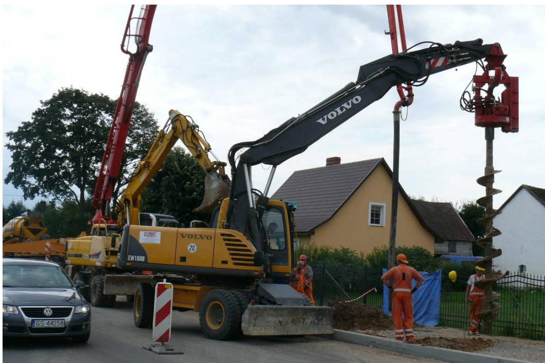
Koparkowa głowica obrotowa CFA typu OWK-3600 zawieszona na koparce kołowej Volvo EW180 – prace na drodze krajowej w okolicach Słupska
